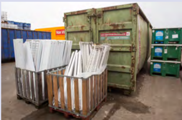
Armaturen verzamelen tijdens sloop werkzaamheden en vervolgens op transport om gerecycled te worden.
