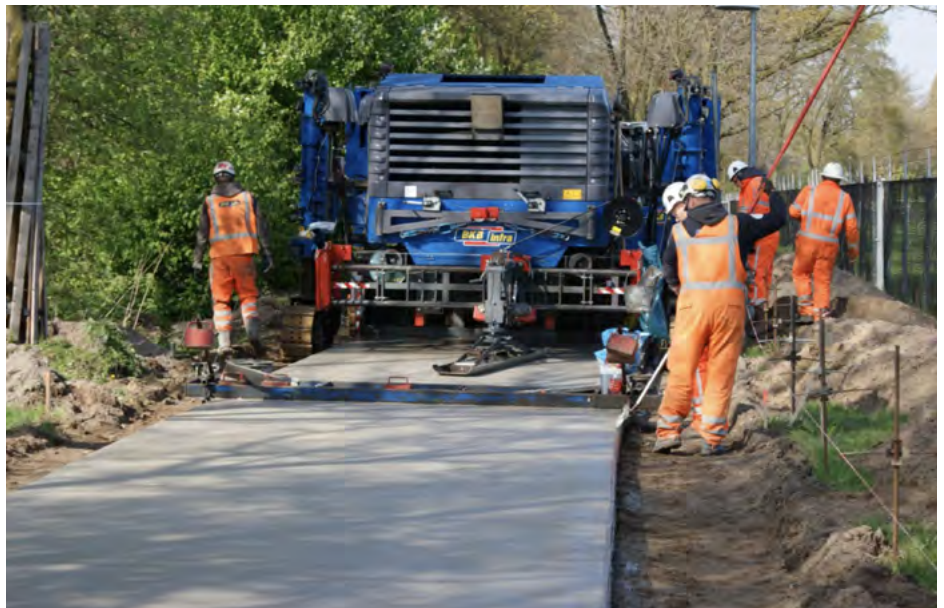
In de gemeente Ede legden de bouwconcerns KWS en Bruil al in 2017 een fietspad aan van duurzaam beton zonder cement.
